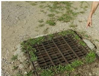
Voyons les faits. Une canalisation a été creusée entre le réseau d'eau potable de la rue du Vieux Village et le Bosquet. Elle aboutit dans une buse, fermée par une grille, ressemblant à celle des avaloirs, mais se situant dix centimètres au-dessus du sol du Bosquet – l'eau de ruissellement ne peut donc y entrer. Cette buse est généralement pleine d'eau, jusqu'à 20cm du bord supérieur.
